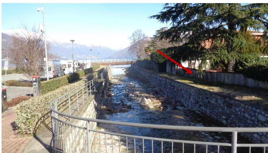
Alveo T. S. Giovanni a valle l'attraversamento della SP394. Si noti il muro che funge da argine in caso di esondazioni in sponda destra idrografica, mentre a sinistra vi è un parapetto metallico.
